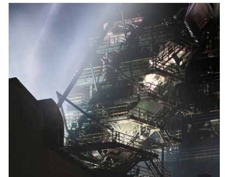
Premier essai d'illumination des hauts fourneaux en 2008
