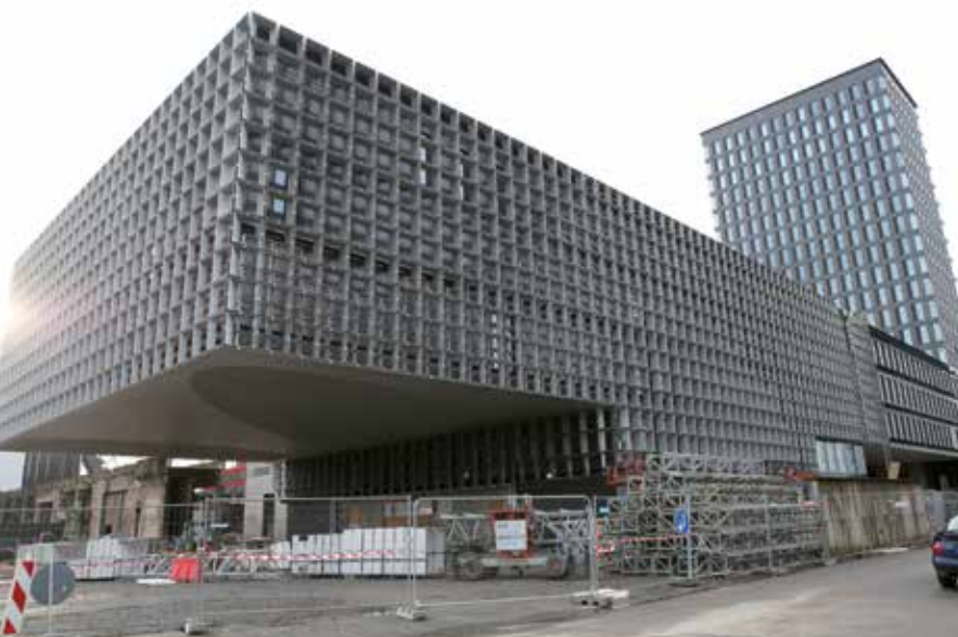
La Maison du Savoir - montage de la façade en aluminium
